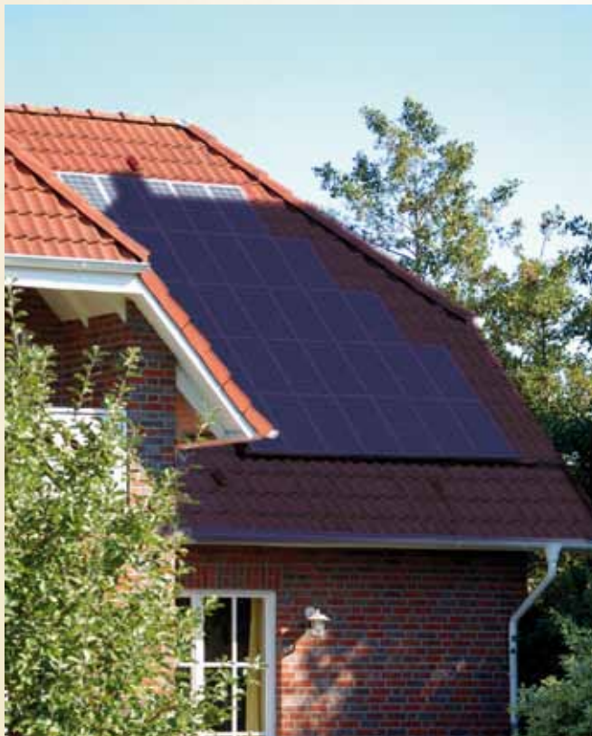
Installation de panneaux photovoltaïques dans l'ombre
