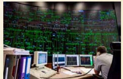
Dispatching / répartition régionale de la région Est à Villers-les-Nancy : dispatcheur à son poste opérateur ; panneau synoptique à l'arrière plan.
